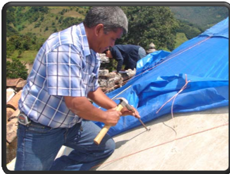
Figura 10. Exterior de Cúpula en Presbiterio, momento donde se investiga las capas de repellos que le han sobrepuesto
