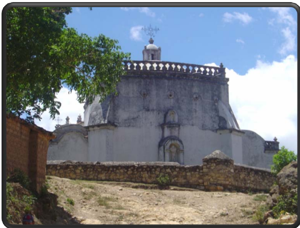
Figura 4. Fachada Este del Presbiterio
