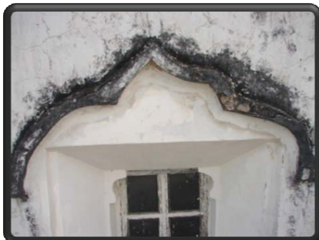
Figure 16. Aro flameado en remate superior de las ventanas del presbiterio
