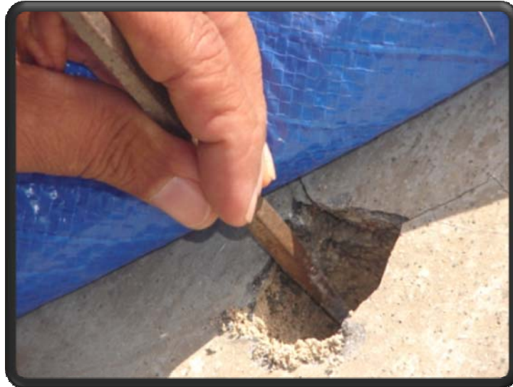
Figura 11. Detalle de Investigación de las diferentes capas de repello superpuestas al enlucido original
