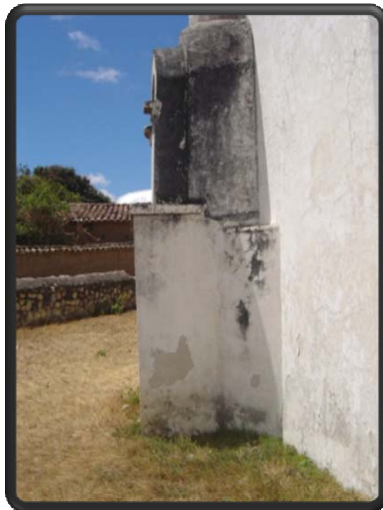
Figura 6. Vista Lateral del Nicho o Altar "Tipo Capilla Abierta" en fachada este
