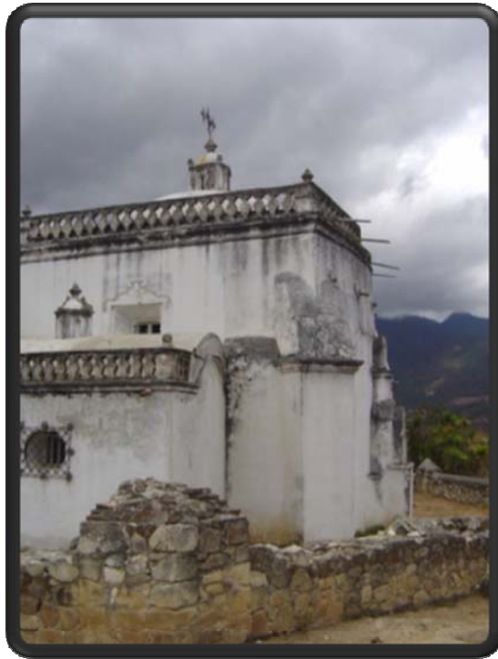
Figura 1. Fachada Suroeste del Presbiterio
