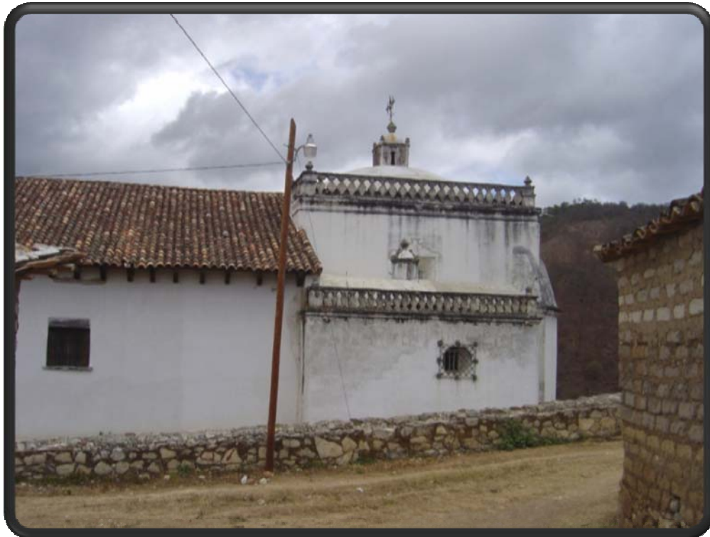
Figura 3. Fachada suroeste del Presbiterio y Nave
